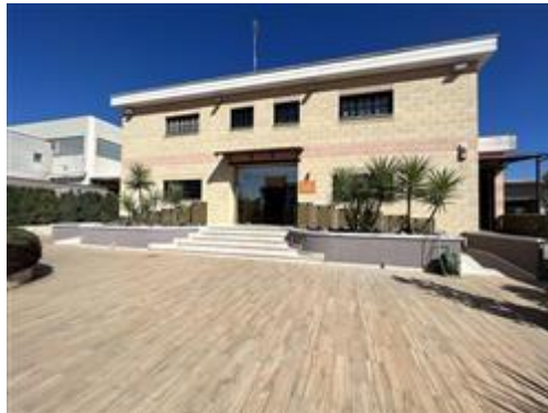
Prospetto su via Aristofane
