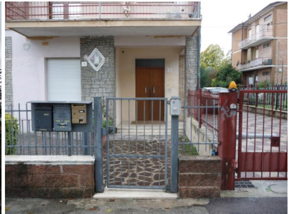
Foto 6 = lato NE - ingresso vano scala
