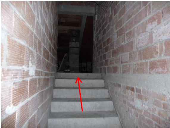
Foto 19 = scala comune accesso piano soffitte
