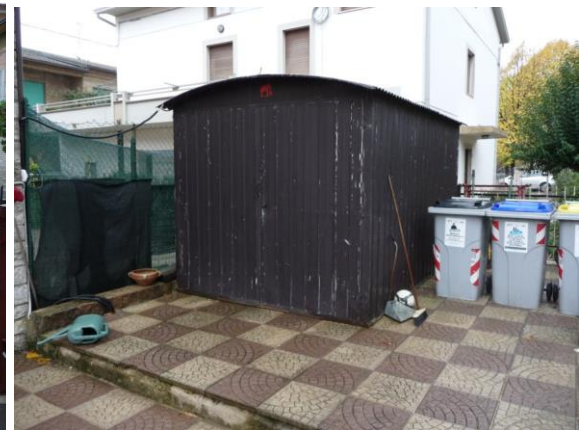
Foto 8 = box metallico abusivo
