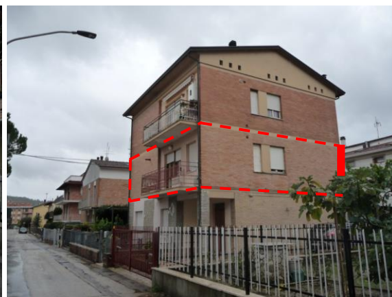
Foto 2 = vista da via del Volo - lati NO/NE
