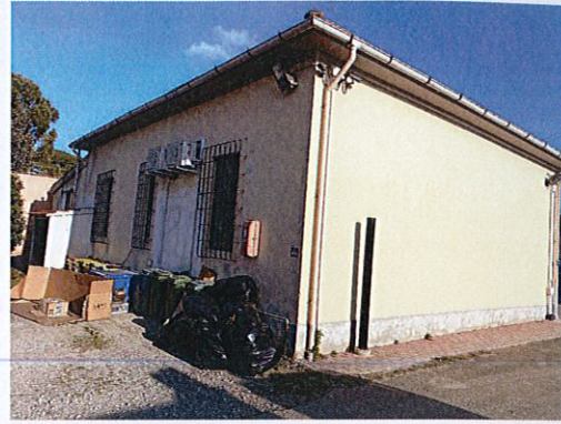
FOTO 2: Vista prospettica edificio (lato Nord-Ovest)
