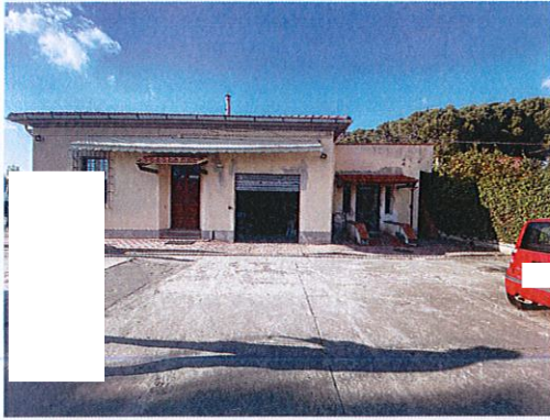
FOTO 1: Particolare facciata edificio (lato sud)
