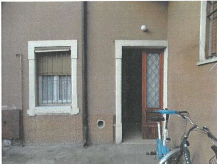
Illustrazione 2: esterno del fabbricato
