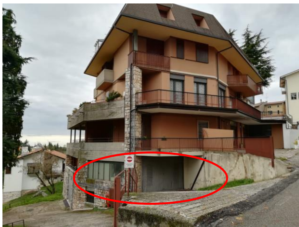
prospetto principale su Via Rotteglia
