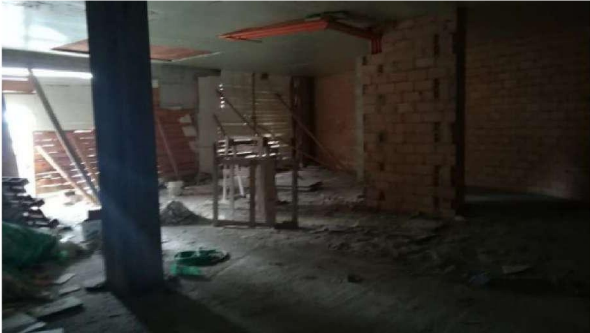
N. 31 - interni sub 25-3
