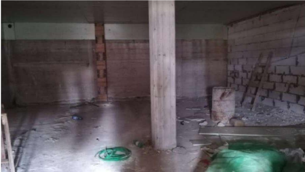
N. 29 - interni sub 25-1
