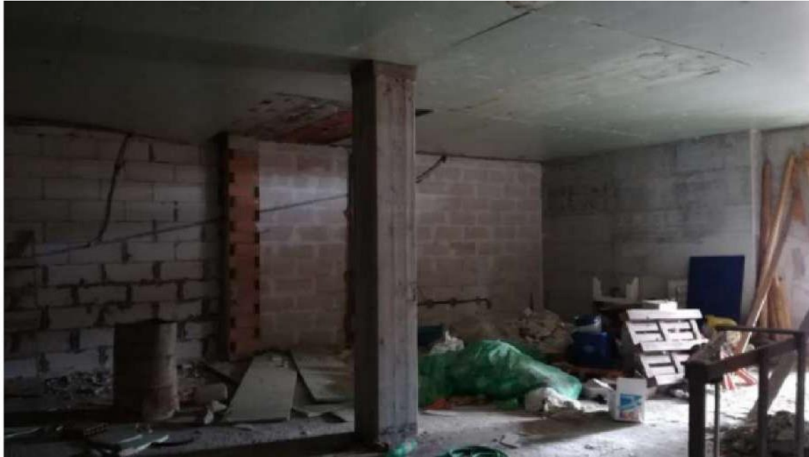
N. 33 - interni sub 25-5
