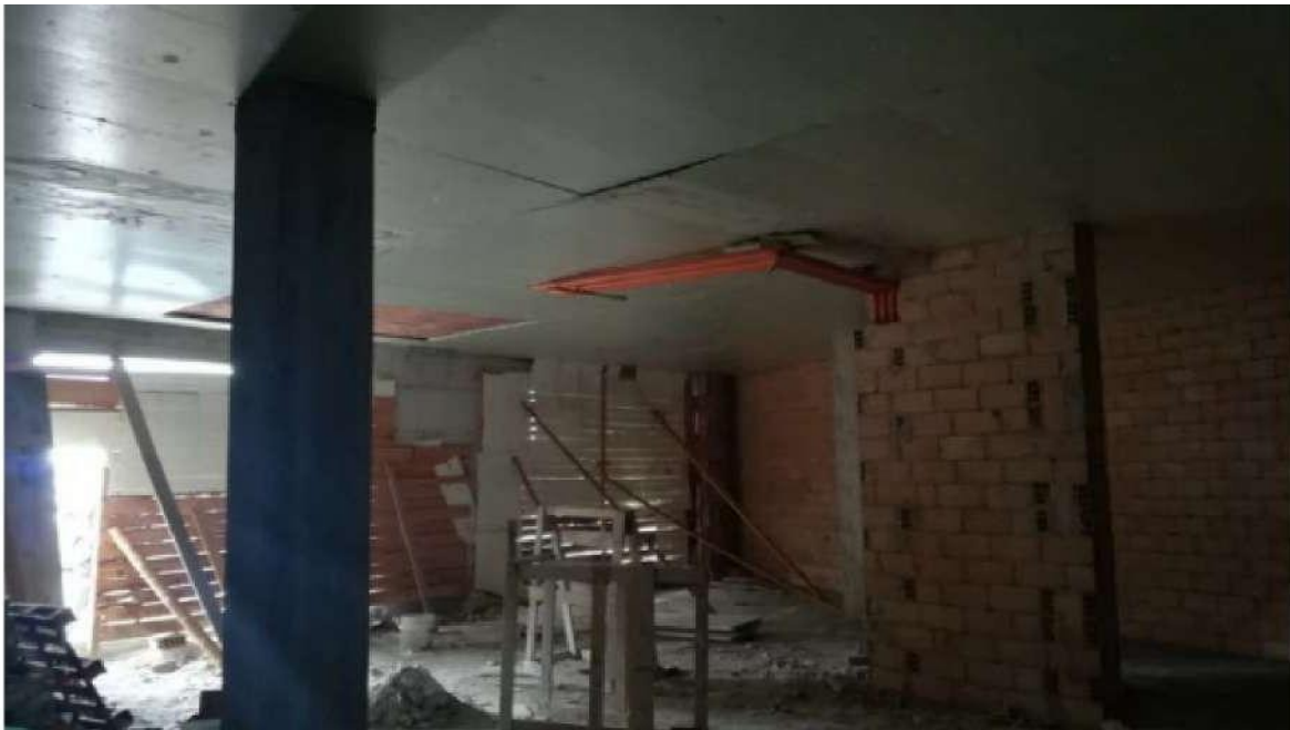
N. 32 - interni sub 25-4
