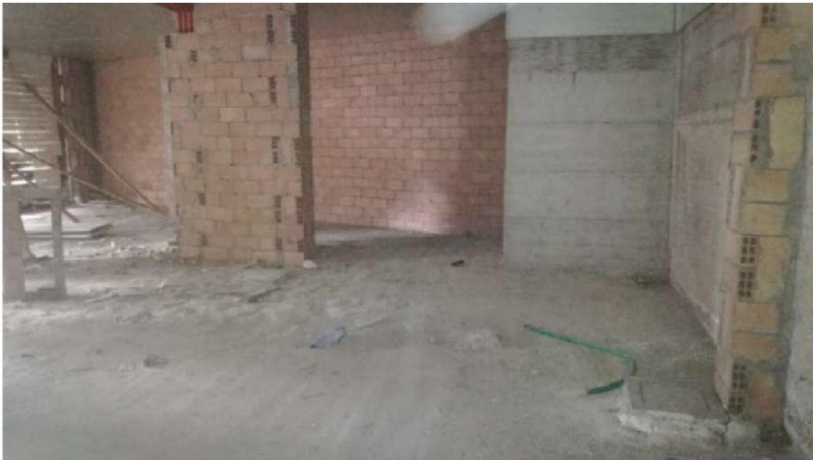
N. 30 - interni sub 25-2
