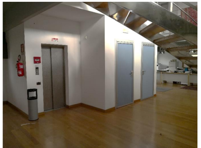
Area vano scala-ascensore uffici – Piano 1°
