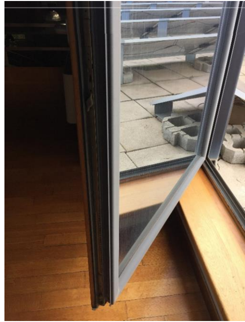
Particolare infisso – Piano 2°
