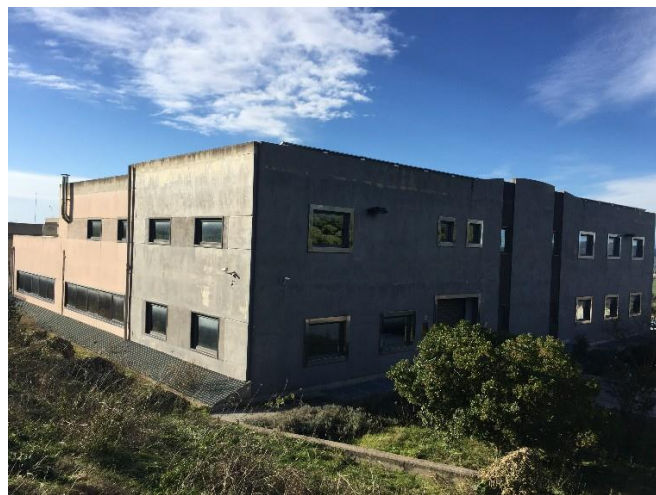
Scorcio prospetto nord/est
