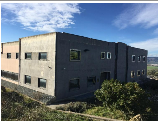
Scorcio zona uffici prospetto nord/est
