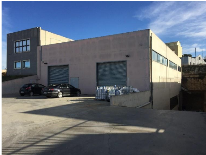
Scorcio zona laboratorio prospetto sud/ovest
