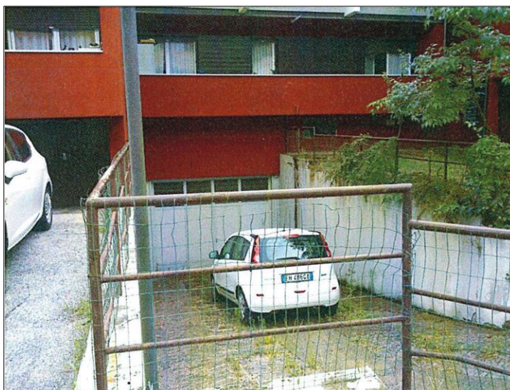
Ingresso autorimessa interrata (da p.e.)
