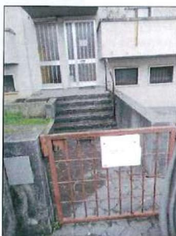
Il vano scala corrispondente al Civico 158 di Via Roma, che permette l'accesso, complessivamente, a n. 6 unità a destinazione residenziale, ha superfici verticali/orizzontali/inclinate intonacate/tinteggiate; rivestimento rampe scale/pianerottoli, in genere, in marmo locale; ringhiere di protezione in ferro complete di corrimano in
