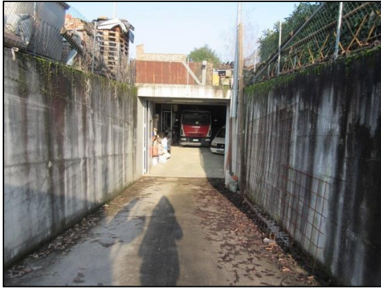
rampa di accesso all'interrato
