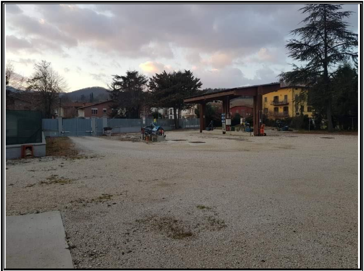
Foto n. 8 – Veduta del piazzale dove sono collocate le cisterne interrato, la pensilina con il fotovoltaico (p.lla 736 sub.1) e del piazzale utilizzato come accesso carrabile (p.lla 736 sub. 2)
