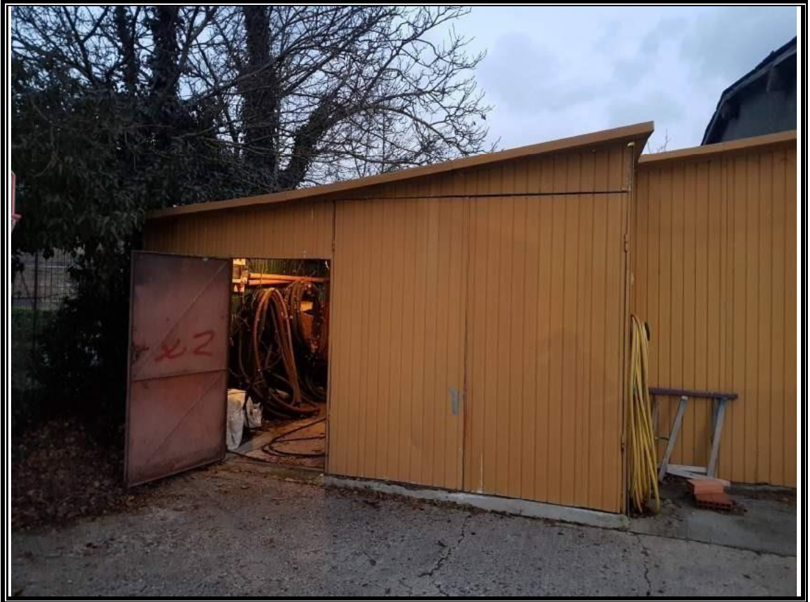
Foto n. 5 – Particolare del locale tettoia-ripostiglio (p.lla 99 sub.28)
