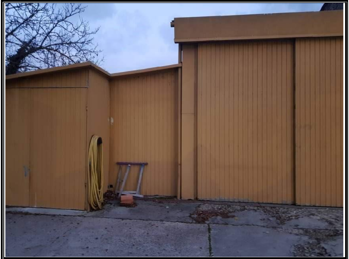
Foto n. 4 – Particolare del locale tettoia-ripostiglio (p.lla 99 sub.28)
