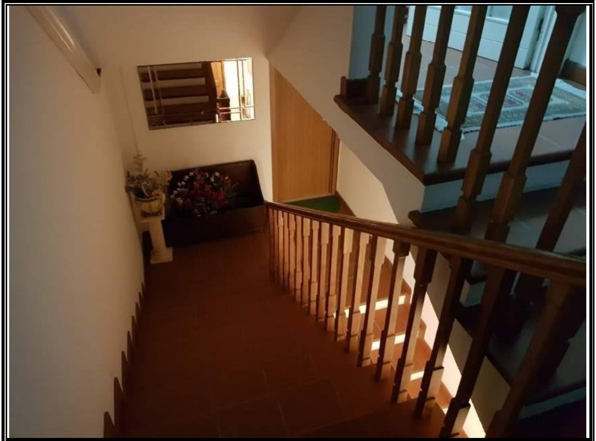
Foto n. 6 – Particolare della rampa di scale (p.lla 99 sub. 25)
