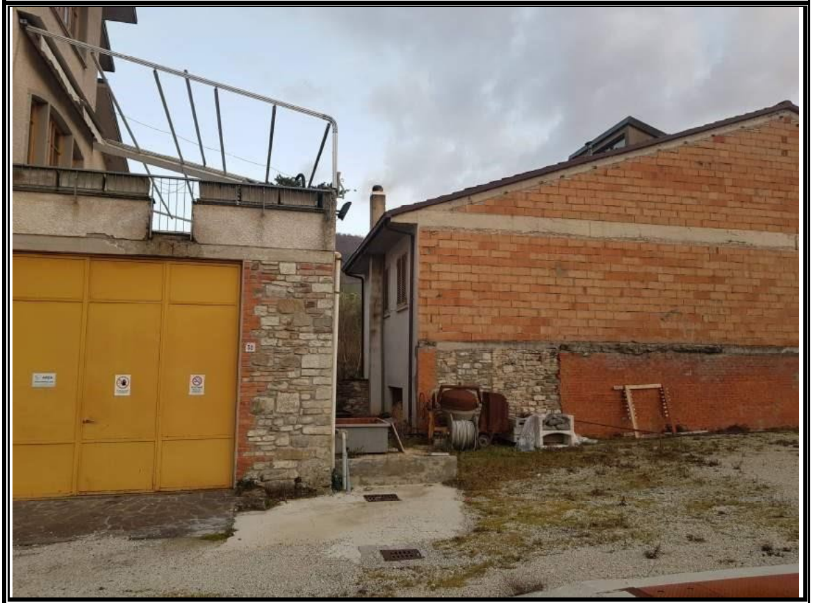
Foto n. 1 – Particolare del deposito oli lubrificanti (p.la 99 sub. 8)
