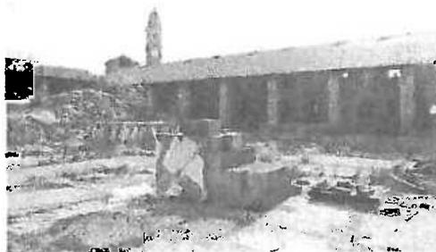
Per quanto attiene al corpo di fabbrica ad uso "abitativo" (mn°45/501 lato Nord)), si rileva che lo stesso è **totalmente inagibile** a causa di crollo delle strutture cui al manto di copertura e solai piani.
