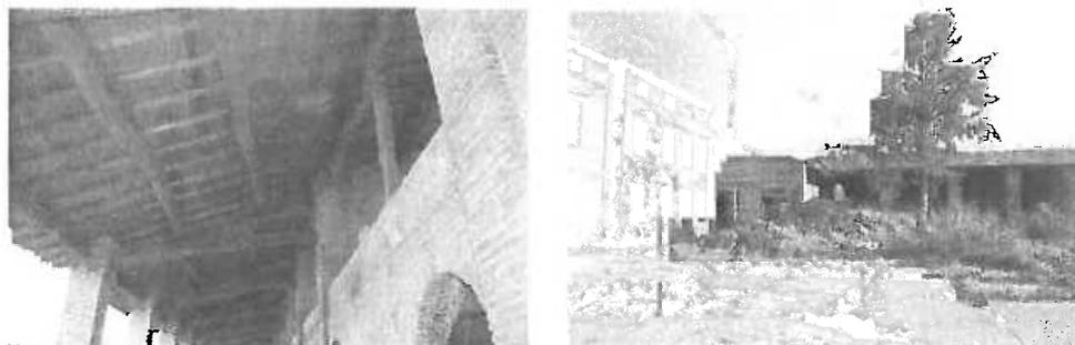
Complessivamente, il compendio risulta in **PESSIMO STATO CONSERVATIVO**, dovuto al rovinoso **stato di abbandono**, con fabbricati parzialmente crollati, sprovvisto di finiture interne e/o esterne alcune (pavimentazioni, serramenti, impiantistica, ecc.); fatta eccezione per i manti di copertura dei mn°45/502, mn°45/503 e "rustico" mn°45/501 (lato Est), recentemente ristrutturati nella struttura e nell'estradosso con impermeabilizzazione e coppi di terracotta.
