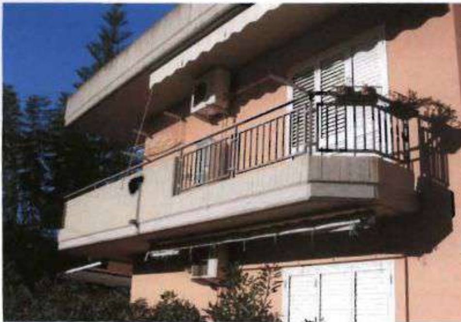
Foto 13: Vista appartamento lato est
