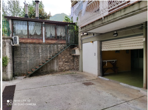
Fig. 17 – Vista del box al piano S1 –
