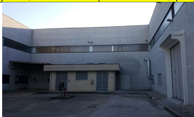
Foto 4: Prospetto N-E (vano compressori tra gli Opifici 3 e 4)
