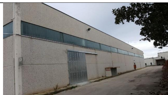
Foto 2b: Prospetto S-E (Opificio 1)
