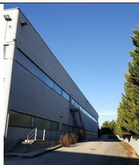
Foto 2b: Prospetto S-E (Opificio 3)
