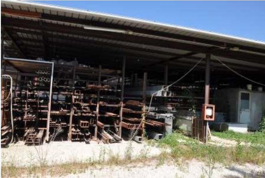
Fotografia n.5 – Altra visuale della porzione porticata “B” realizzata per mezzo di struttura in ferro destinata al deposito dei materiali edilizi.
