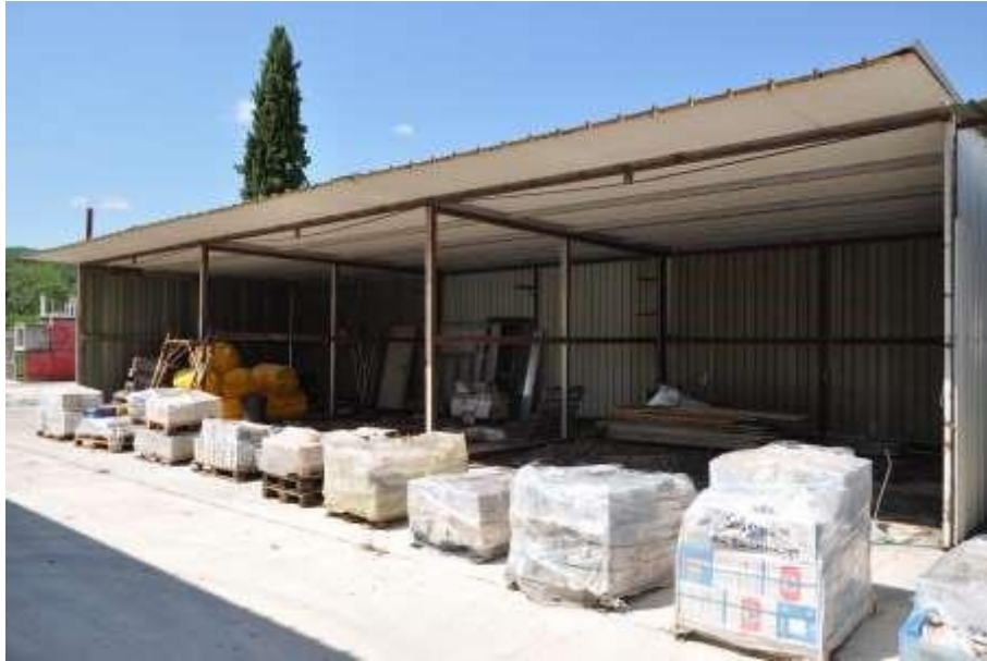
Fotografia n.9 – Visuale della porzione porticata “D” realizzata per mezzo di struttura in ferro destinata al deposito dei materiali edilizi.
