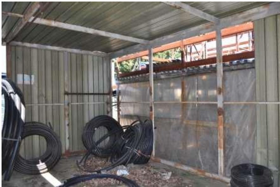
Fotografia n.10 – Visuale della porzione porticata “D” realizzata per mezzo di struttura in ferro destinata al deposito dei materiali edilizi.
