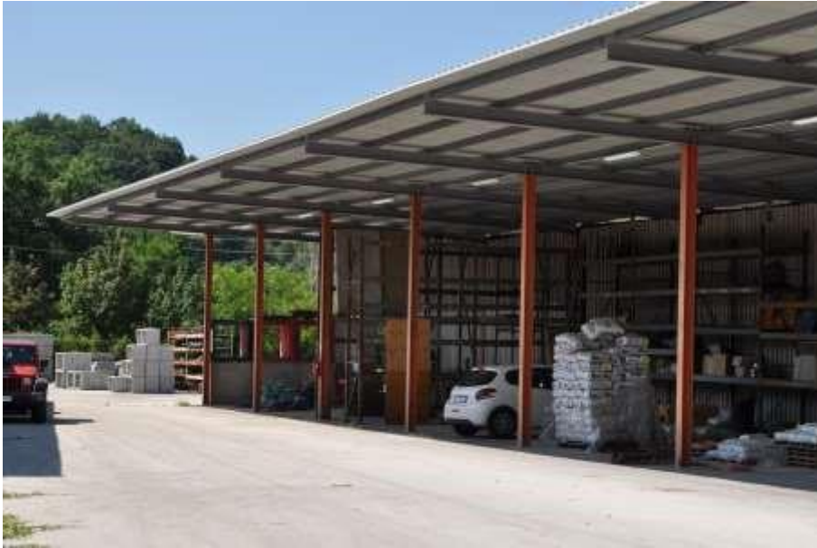
Fotografia n.7 – Altra visuale della porzione porticata “C” realizzata per mezzo di struttura in ferro destinata al deposito dei materiali edilizi.
