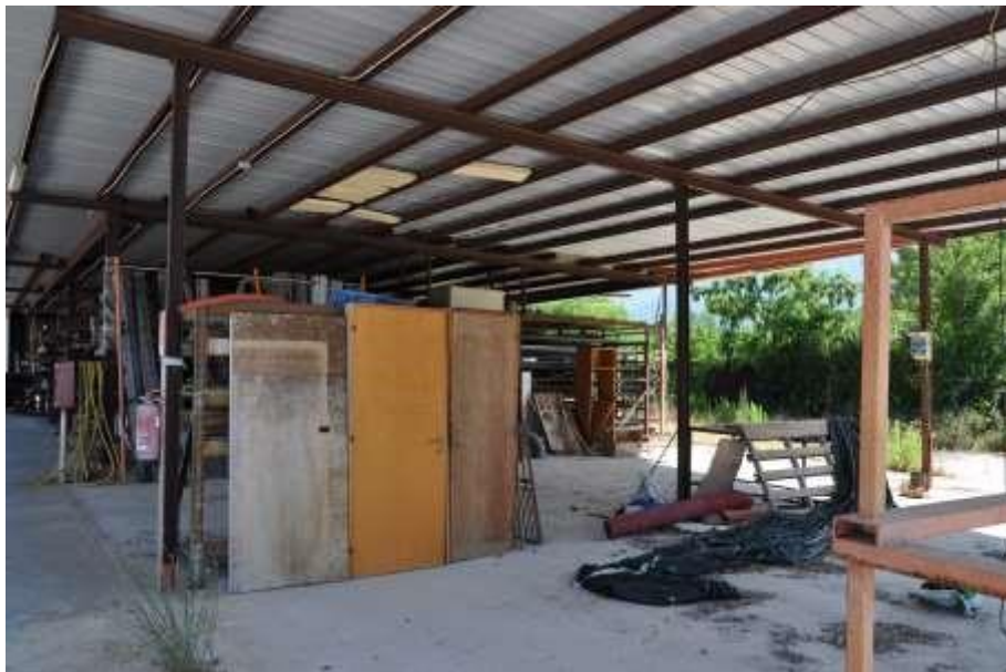
Fotografia n.4 – Visuale della porzione porticata “B” realizzata per mezzo di struttura in ferro destinata al deposito dei materiali edilizi.
