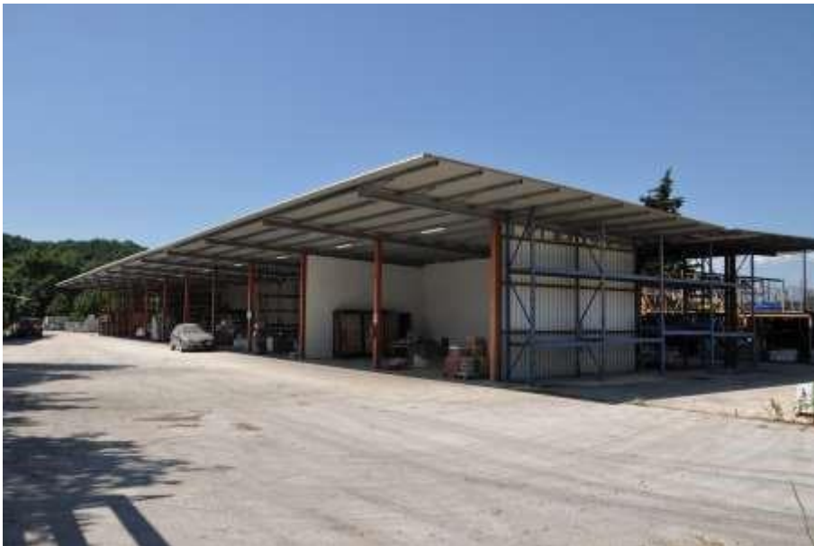
Fotografia n.6 – Visuale della porzione porticata “C” realizzata per mezzo di struttura in ferro destinata al deposito dei materiali edilizi.
