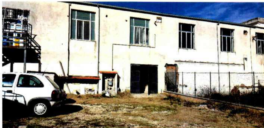
Foto 2 - Prospetto del piano seminterrato e del piano terra
