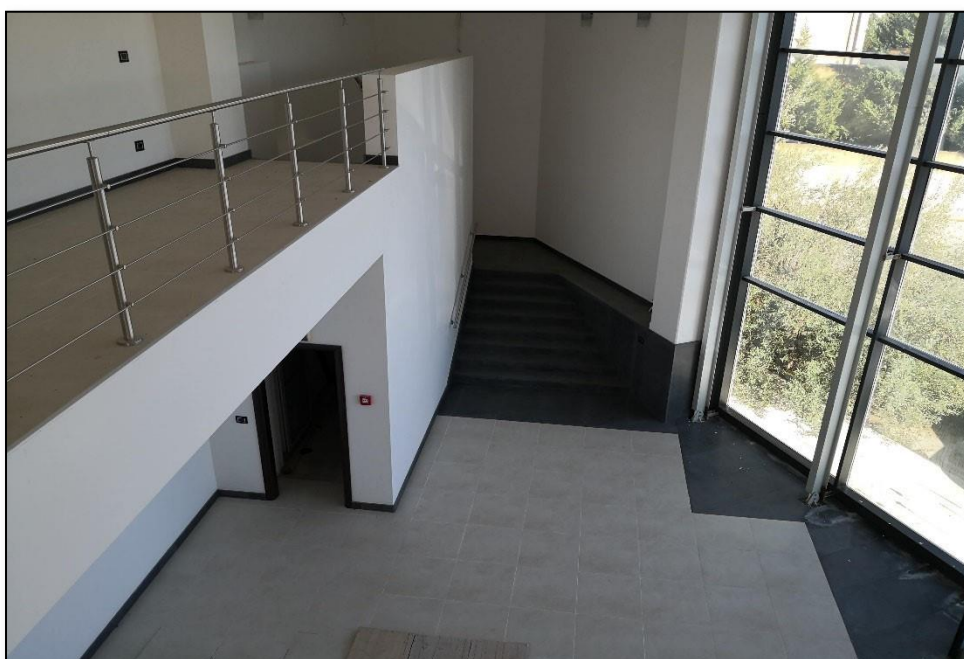
hall d'ingresso e scala
