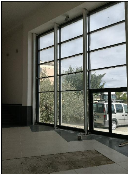
Pavimenti della hall d'ingresso
